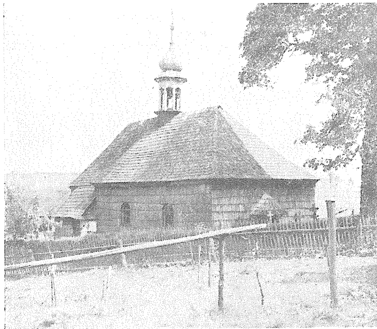
Dřevěný kostelík v Lipné. (Snímek z archivu Památkového úřadu v Brně.)
