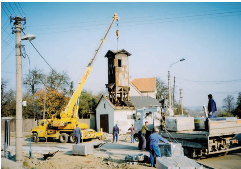
..●● Bourání věže hasičské zbrojnice (hrozila zřícením), 9. listopadu 2005
