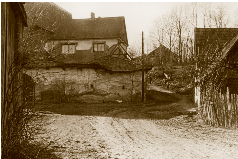
..●● Hospodářské budovy Doskočilova mlýna v rozvalinách, vzadu pila, 1956
