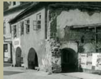
▲ Dům čp. 731 před demolicí, v roce 1936 na jeho místě vystavěl rodinný dům MUDr. Artur Glüčk.
