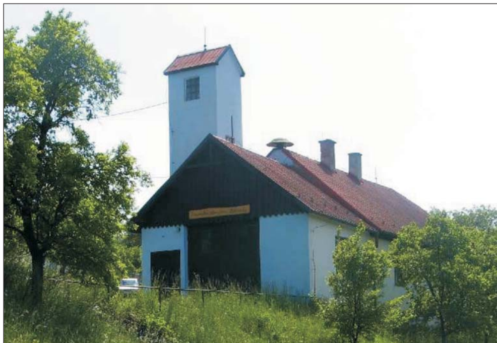
Hasičská zbrojnice v Zámorskách
