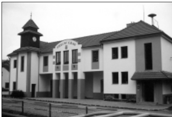
■ Hasičská zbrojnice s obecním úřadem
