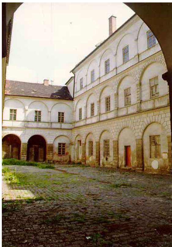
Nádvoří zámku před rekonstrukcí
