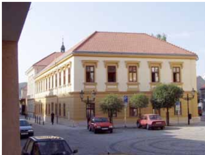
Budova č.p. 118 po rekonstrukci (srpen 20023)
