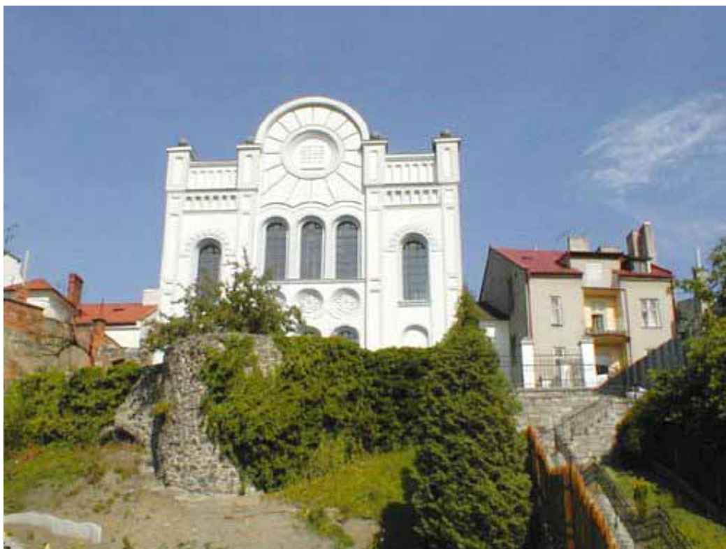
Synagoga po provedené rekonstrukci – pohled ze západu
