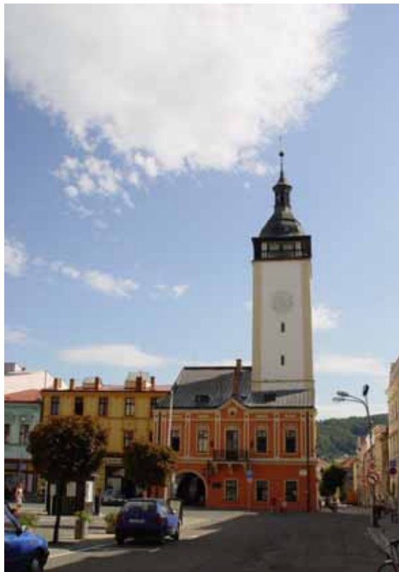
Bývalá radnice, č.p. 71 – stav po rekonstrukci
