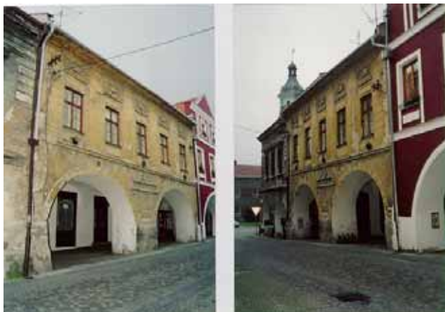
Měšťanský dům č.p. 31 před obnovou (nahore)
