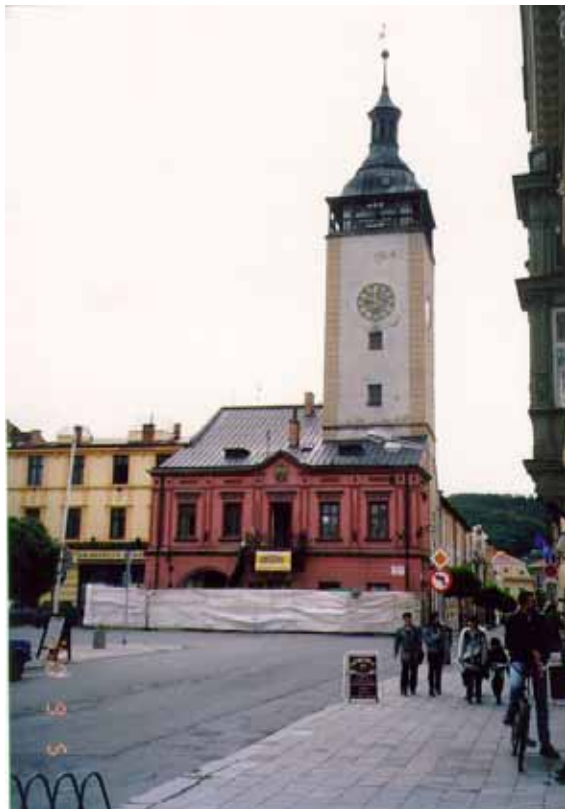
Bývalá radnice, č.p. 71 – provádění stavebních prací
