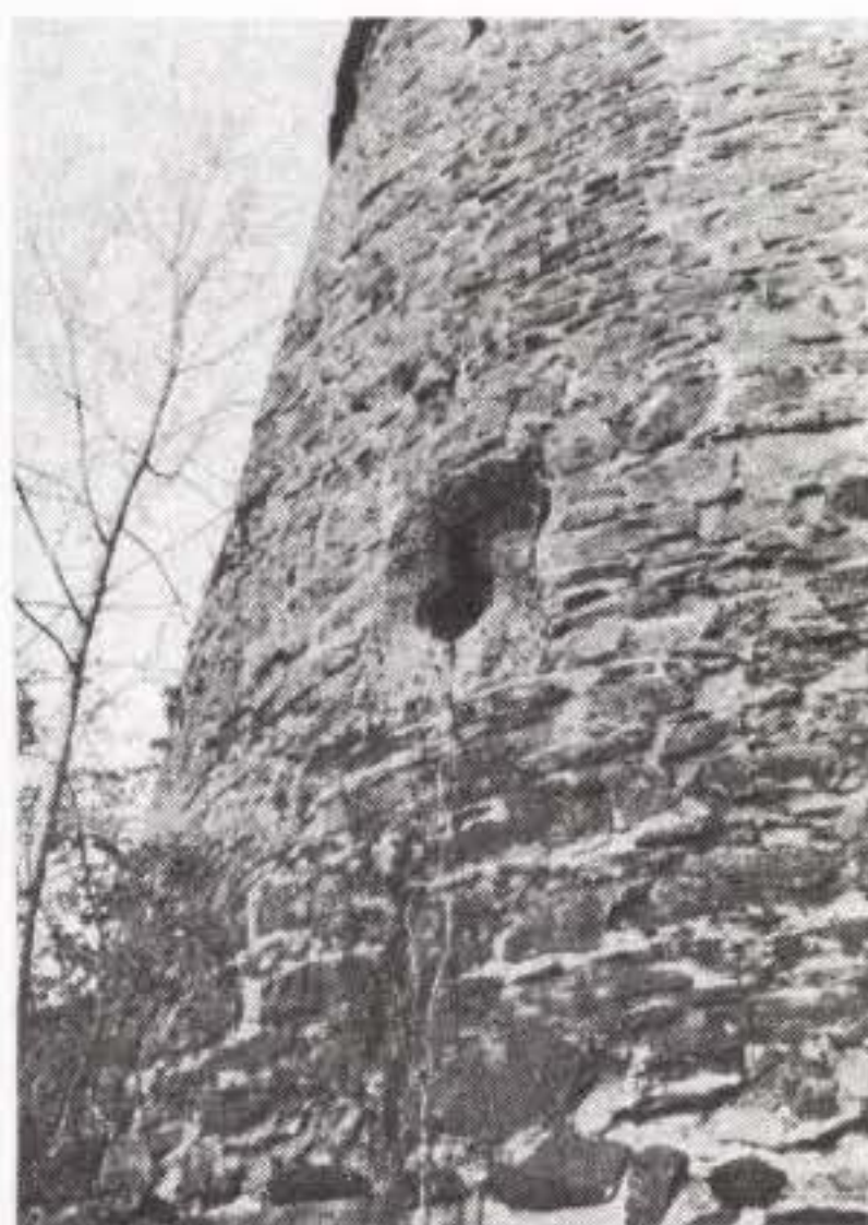
Obr. 14. JZ bašta Předzámčí s klíčovými střelnami.
