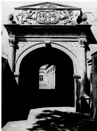
Obr. 3. Hranice na Moravě (okres Přerov), zámek. Pohled na vstupní portál po 1. 7. 1992, s patrnou nespokojostí archivolty. (Foto archiv Památkové inspekce MK ČR)
