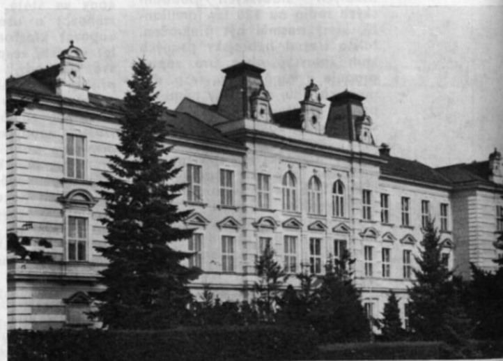
BUDOVA STŘEDNÍ LESNICKÉ ŠKOLY V HRANICÍCH
