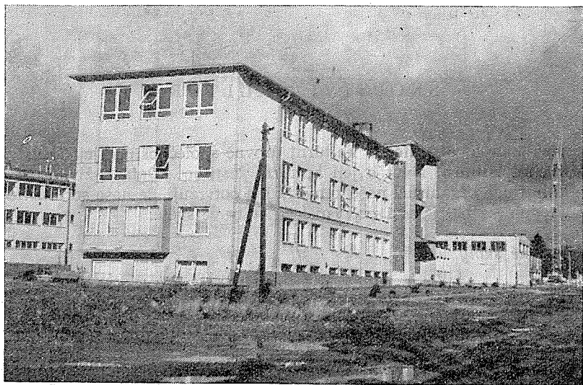
Nová budova Průmyslové školy stavebních hmot a Průmyslové školy dřevařské. V pozadí rozestavěná budova Domova mládeže pro 240 studentů.
