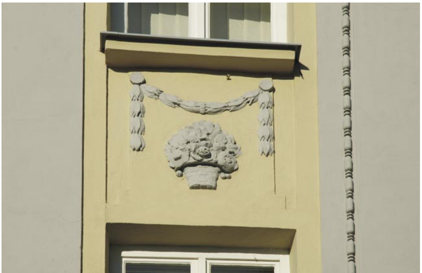
•• Detail fasády domu čp. 90.
