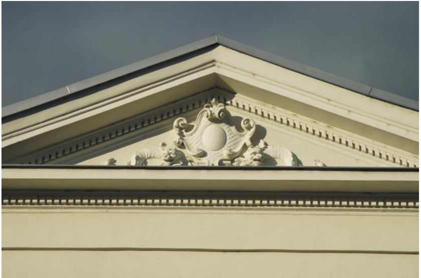
•• Detail fasády domu čp. 50.
