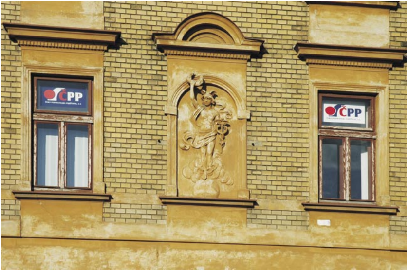
•• Detail fasády domu čp. 92.
