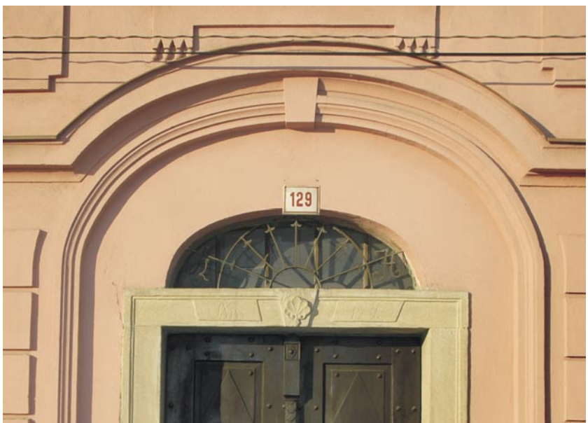
•• Detail fasády domu čp. 129.
