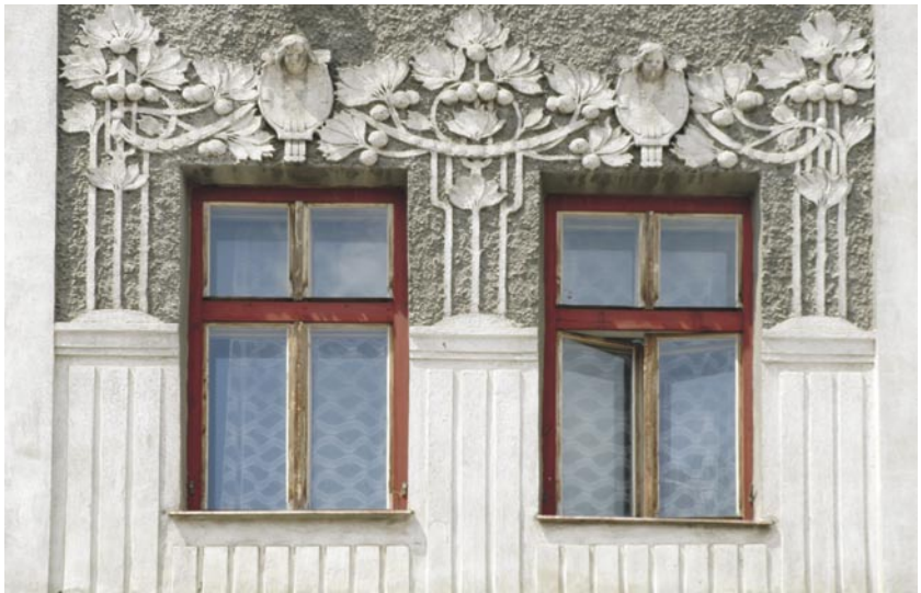
•• Detail fasády domu čp. 734.
