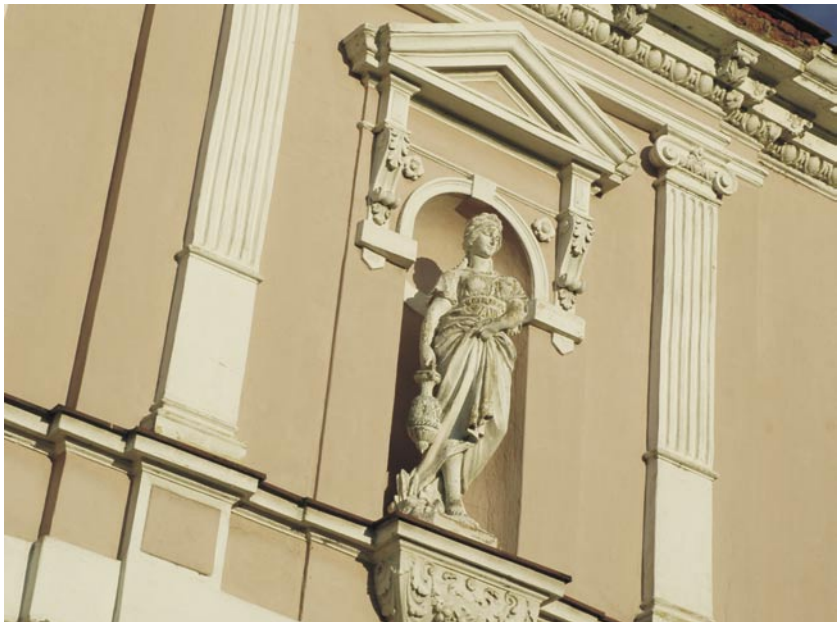
•• Detail fasády domu čp. 448.
