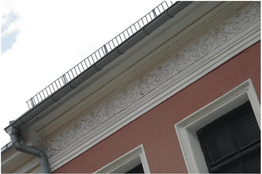
•• Detail fasády domu čp. 26.
