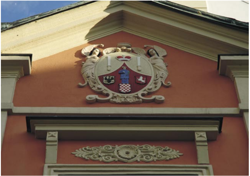
•• Detail fasády domu čp. 71.
