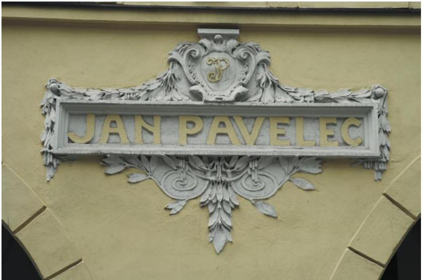
•• Detail fasády domu čp. 31.
