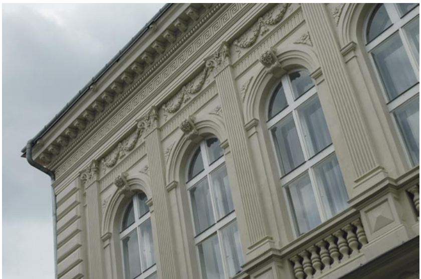
•• Detail fasády domu čp. 118.
