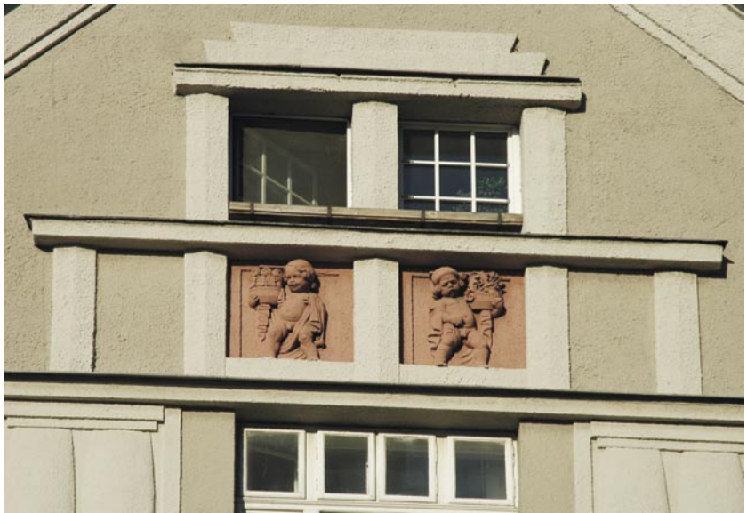
•• Detail fasády domu čp. 89.
