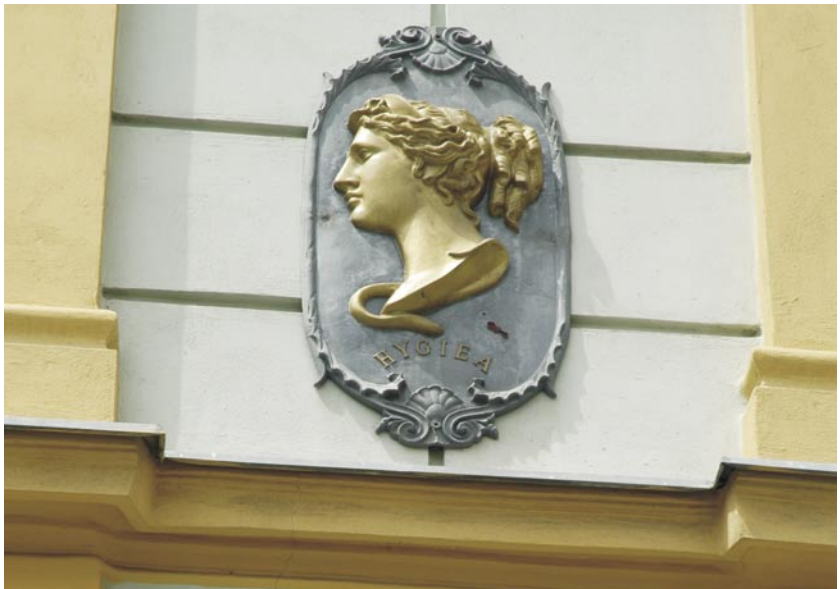
•• Detail fasády domu čp. 5.
