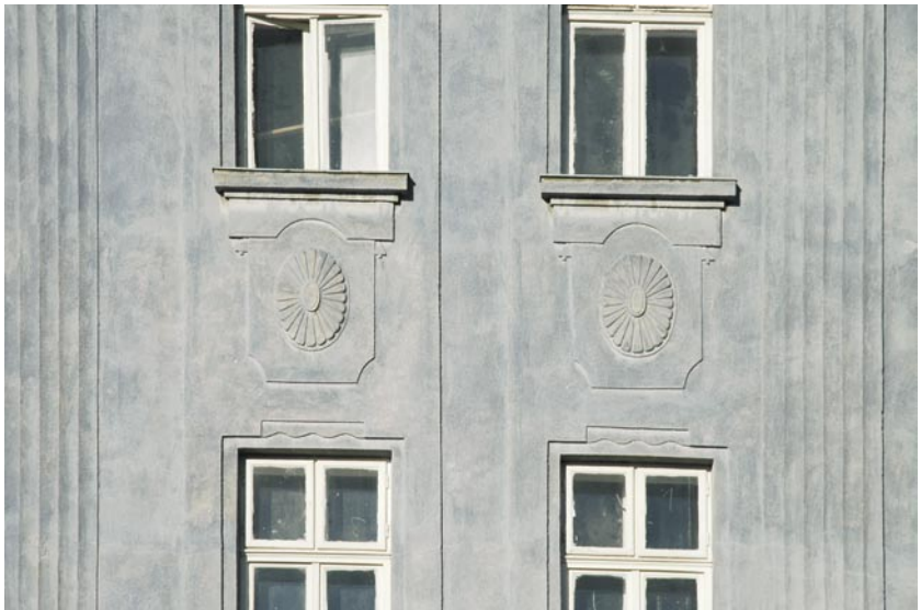
•• Detail fasády domu čp. 93.
