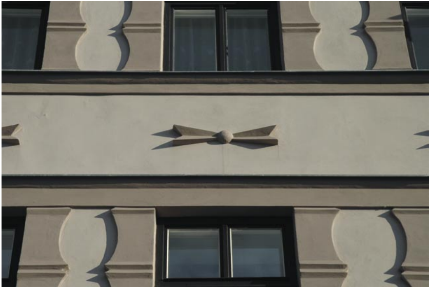
•• Detail fasády domu čp. 74.
