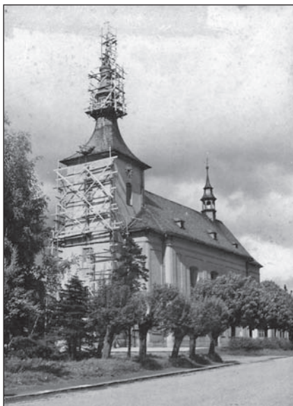
Rekonstrukce věže kostela, 30. léta 20. st. SOKA Přerov
