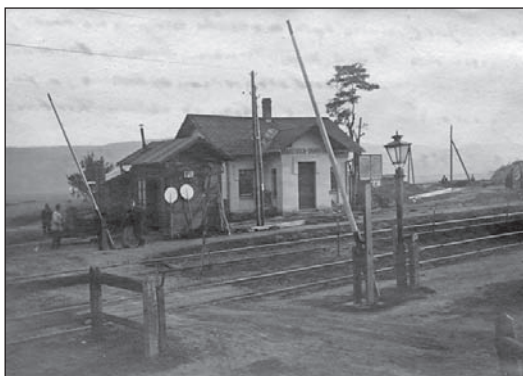
Železniční stanice, duben 1909. ŘKFÚ Drahotuše
