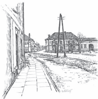
Pohled na západní část náměstí směrem k Lipníku nad Bečvou. Čelně stojí starý dům řezníka pana Jana Hally. O tento dům se kdysi opírala tzv. „Dolní brána“ vystavěná za Pernštejnů v roce 1543. Dům zbořen v šedesátých letech min. století za účelem rozšíření vozovky. Kresba Z. Černý
