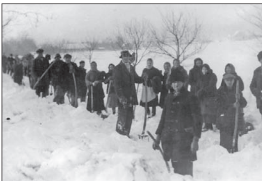
Prohazování sněhových závějů na okresních silnicích a obecních cestách. SOKa Přerov
