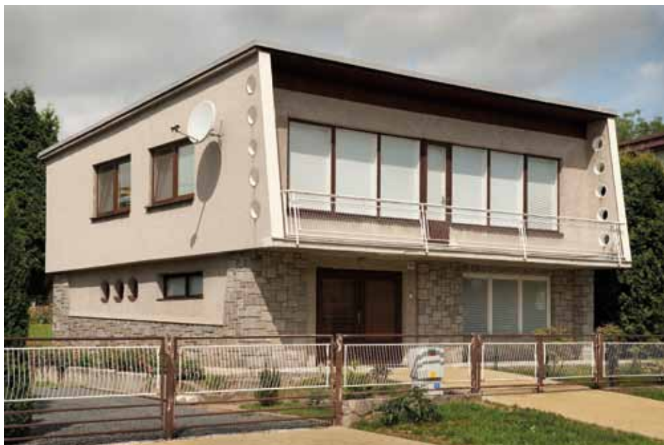
Josef Vaněk: Rodinný dům typu V (tzv. „Šumperák“), stavebník Zdeněk Vykopal, 1974, Hviezdoslavova 1584, foto 2012
