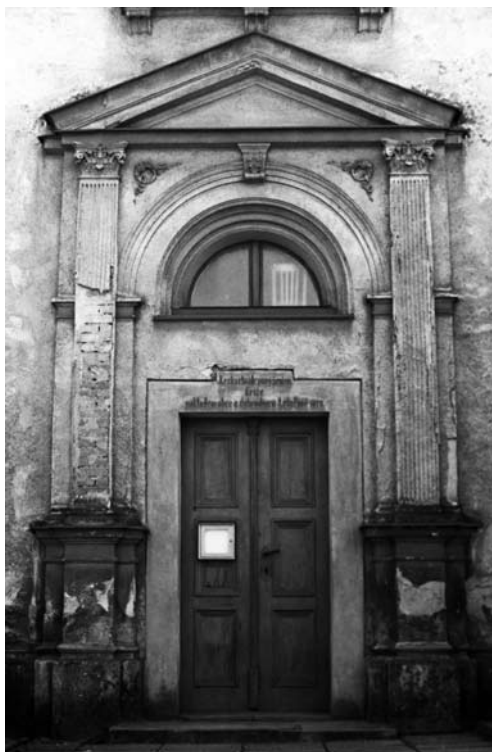
Velká, detail průčelí kaple, 1. 3. 1998
