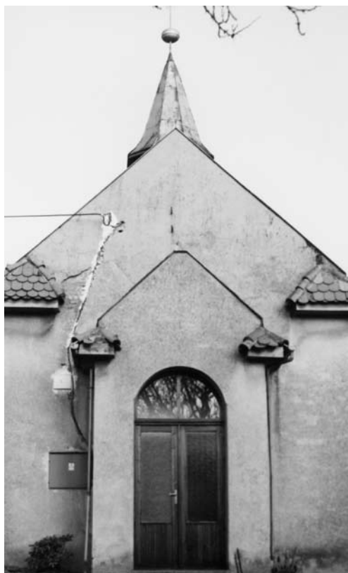
Radíkov, průčelí kaple, 27. 2. 1998
