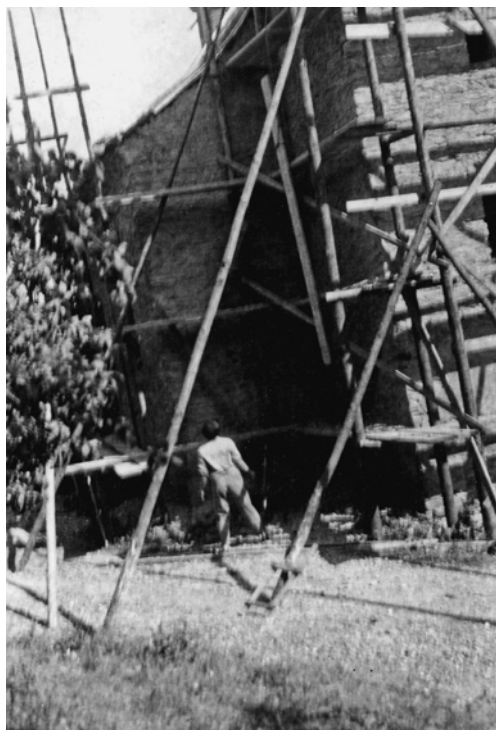
Fotografie z horní strany věže kostela, kde se na lešení již pracuje.
