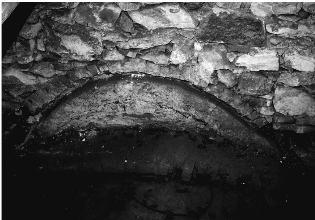
Okno do presbytáře, zazděné při přístavbě sakristie
