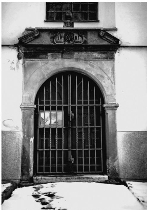
Portál prodloužený v horní části řadou pískovcových kostek
