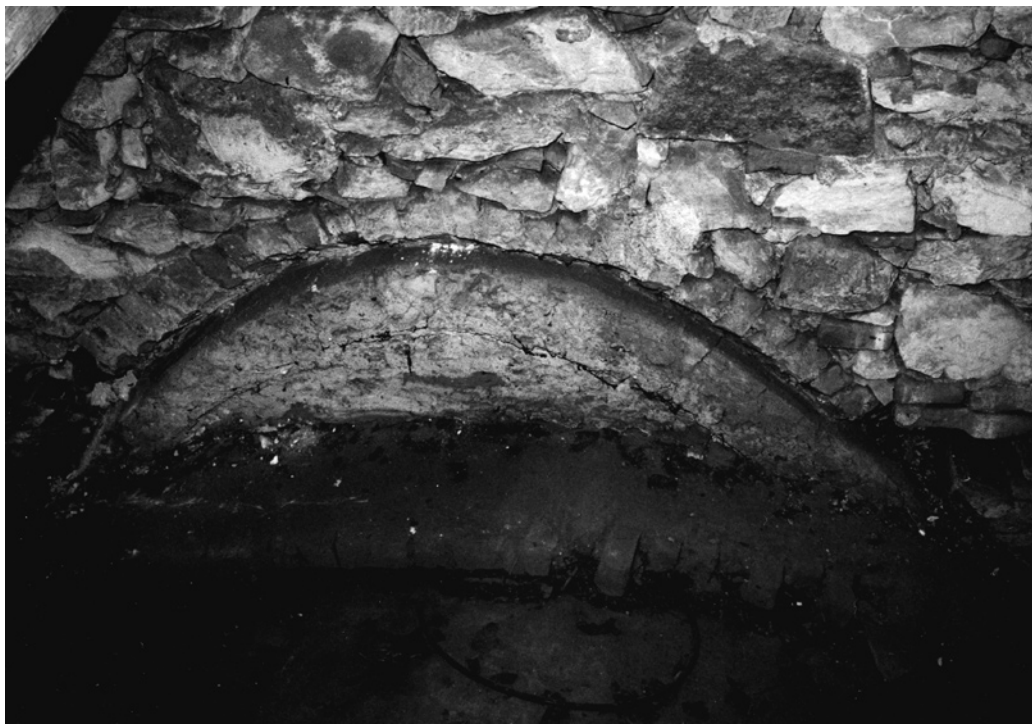
Okno do presbytáře, zazděné při přístavbě sakristie
