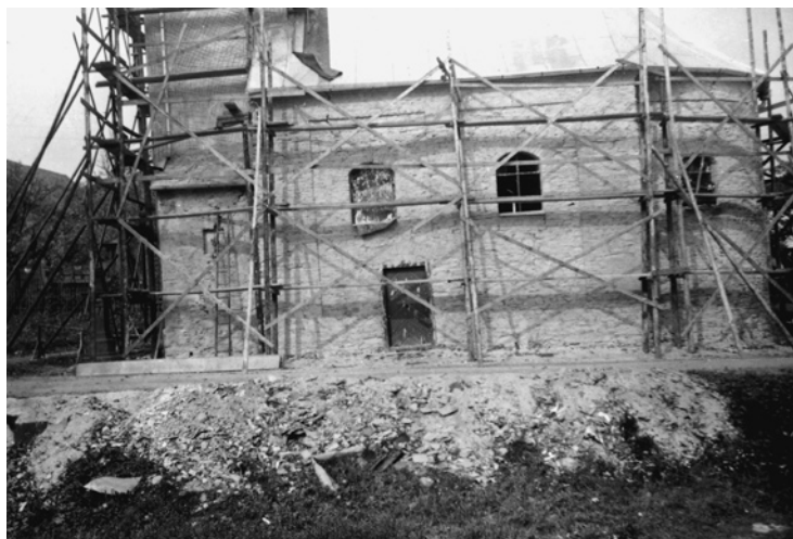
Pomocné dřevěné lešení u kostela sv. Antonína v r. 1971–1972 s jižní strany.
