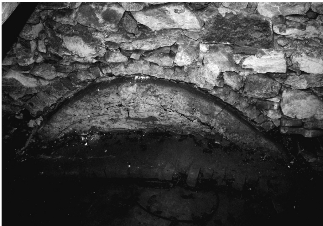
Okno do presbytáře, zazděné při přístavbě sakristie
