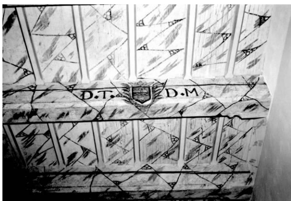
Vzhled stropu po rekonstrukci
