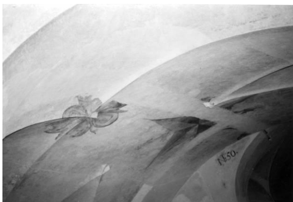
Strop s hvězdou po rekonstrukci
