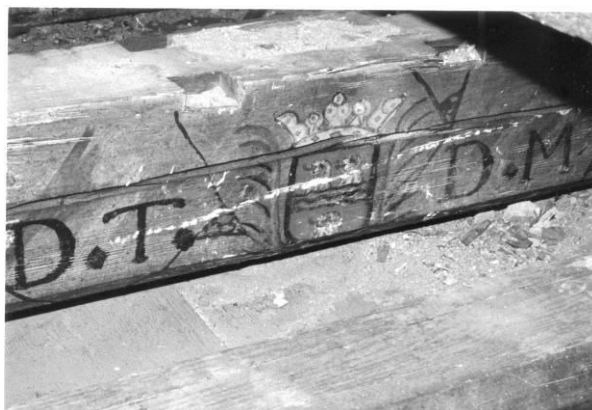
Detail znaku na stropním trámu
