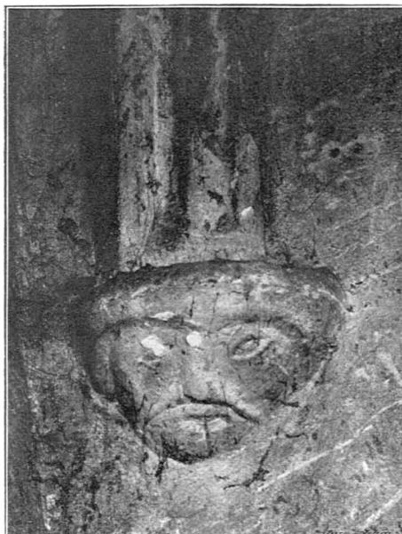
Obr. 7. Konsola pod žebrem kleneb v hlavní lodi.
